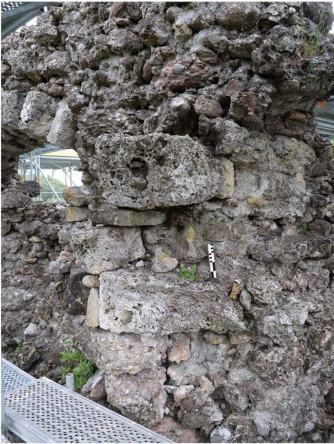
Abb. 23 Schänis SG, Ruine Niederwindegg, 2020. Ecke M1/M2, mit Resten des Eckverbandes aus bossierten Tuffsteinquadern, von Norden.
