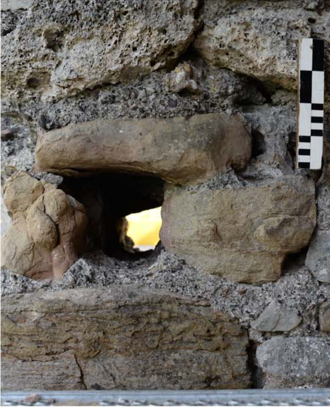
Abb. 21 Schänis SG, Ruine Niederwindegg, 2020. Mauer M1, Innenfassade. Gerüsthebelloch 2.1 mit viereckigem Querschnitt, von Südosten.
