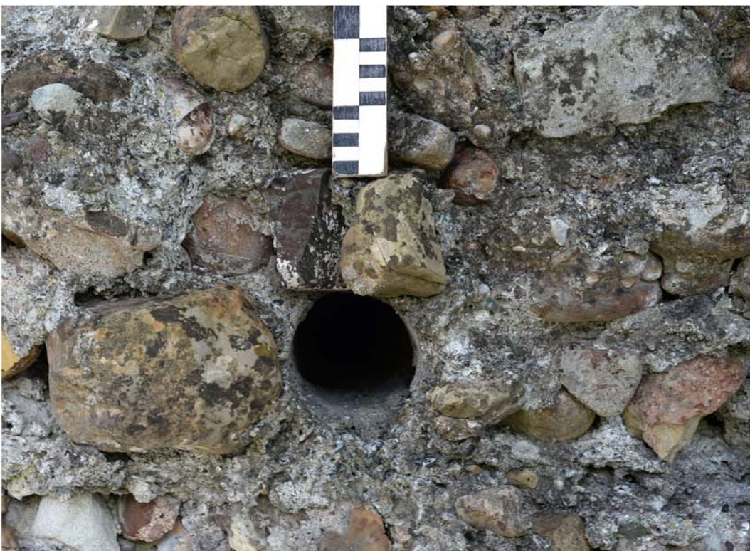
Abb. 20 Schänis SG, Ruine Niederwindegg, 2020. Mauer M1, Aussenfassade. Gerüsthebelloch 1.1 mit rundem Querschnitt, von Nordwesten.
