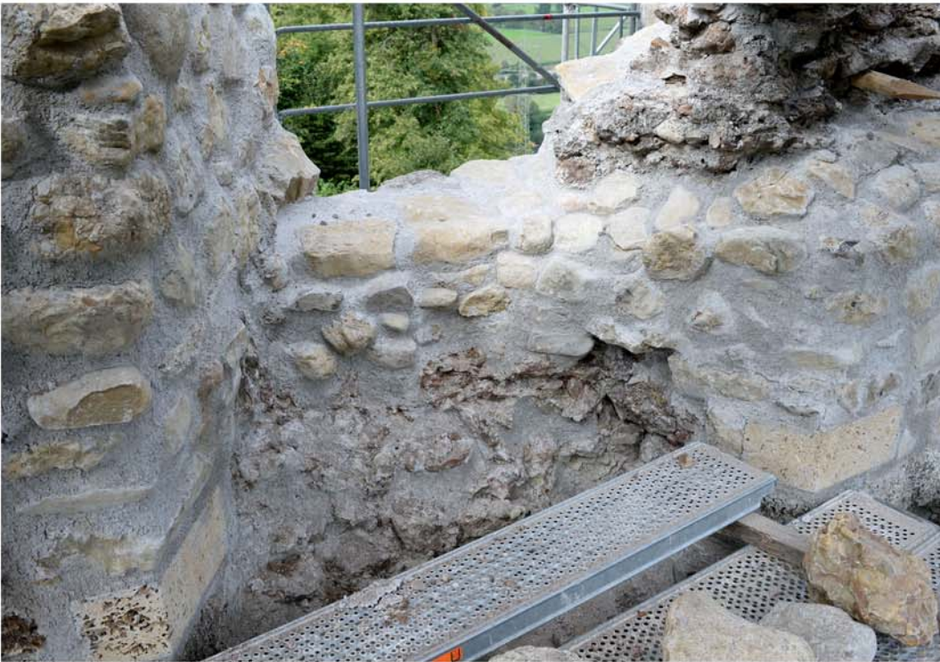
Abb. 29 Schänis SG, Ruine Niederwindegg, 2020. Mauer M2, Öffnung 4 nach Abschluss der Sanierungsarbeiten, von Nordosten.
