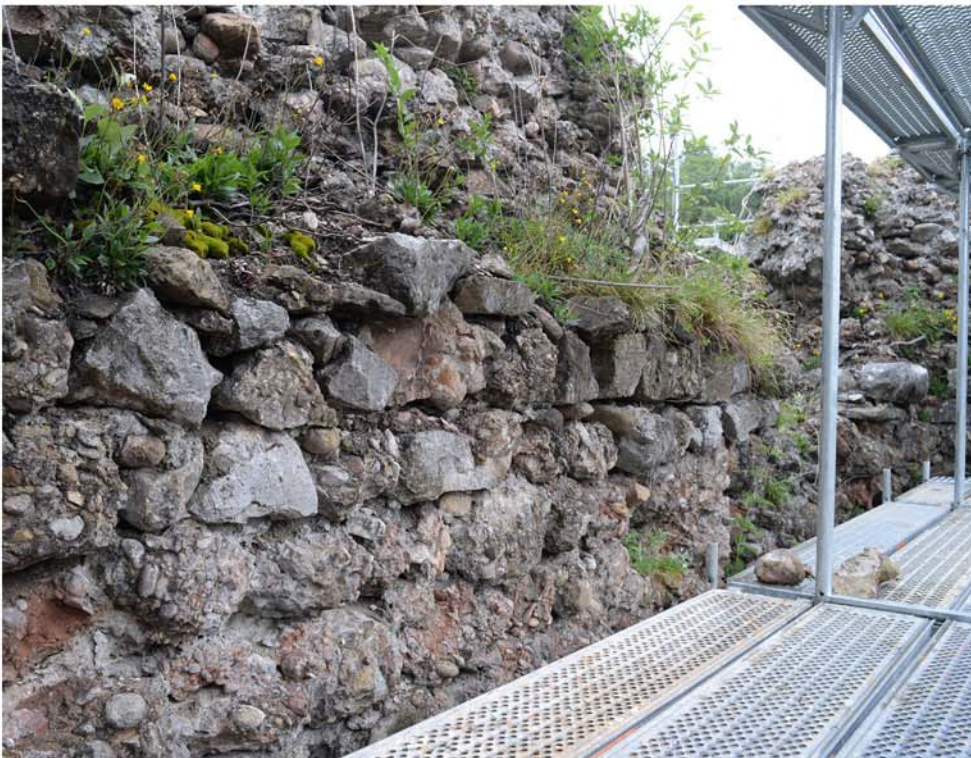
Abb. 10 Schänis SG, Ruine Niederwindegg, 2020. Mauer M2. Abbruchkronen des inneren Mauermantels vor dem Entfernen des Bewuchses, von Westen Darüber erhebt sich überraschend gut erhaltenes Kernmauerwerk.
