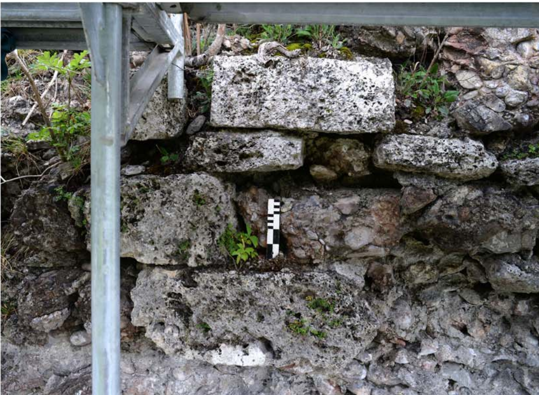
Abb.14 Schänis SG, Ruine Niederwindegg, 2020. Mauer M2. Mauerpartie in der Aussenfassade mit Einlagen aus nicht bossierten Tuffsteinquadern anschliessend an die nordwestliche Leibung der Öffnung 4, von Nordosten.
