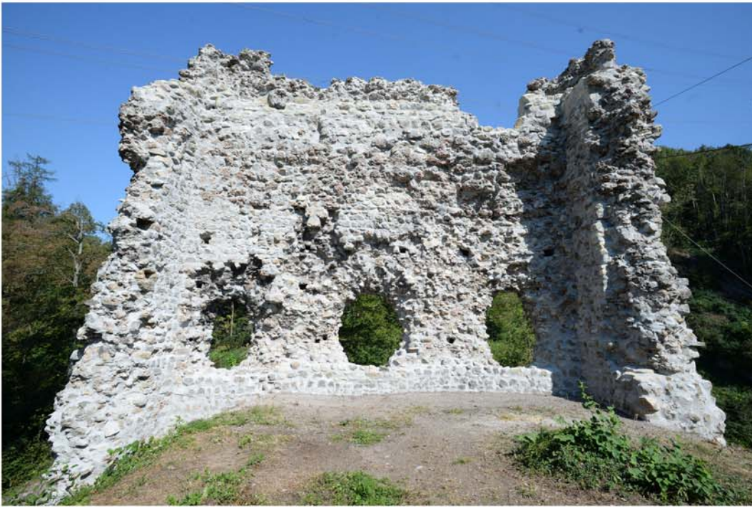
Abb. 33 Schänis SG, Ruine Niederwindegg, 2020. Mauer M1 bis M3, Innenfassaden. Blick auf die fertig in Stand gestellte Ruine, von Südwesten.
