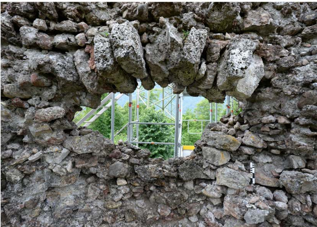
Abb. 16 Schänis SG, Ruine Niederwindegg, 2020. Mauer M2, Aussenfassade. Rest des aus verschiedenen Steinsorten zusammengesetzten Stichbogens über der Öffnung 5, von Nordosten.
