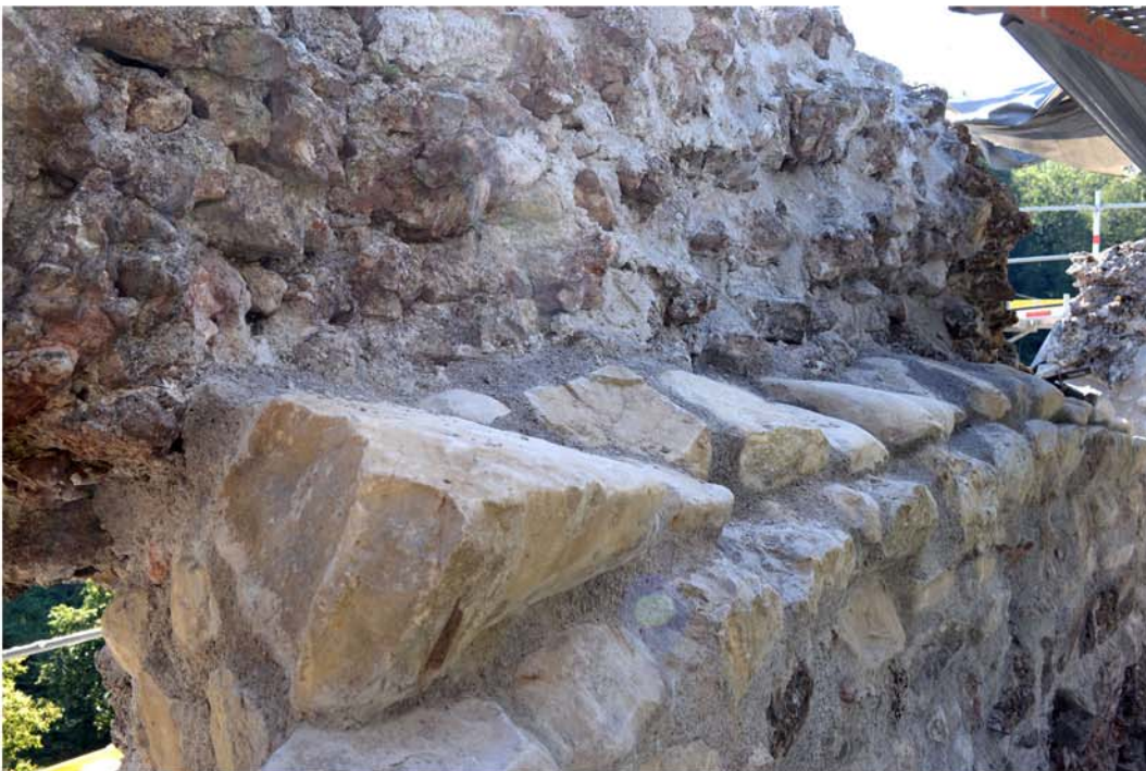
Abb. 12 Schänis SG, Ruine Niederwindegg, 2020. Mauer M2. Mit neu aufgeführtem Mauerwerk abgedeckte Krone des Mauerinnenmantels, von Westen. Die stark gegen aussen geneigte Abdeckung soll in erster Linie verhindern, dass Wasser zwischen Mauerkern und Mauermantel eindringen kann.
