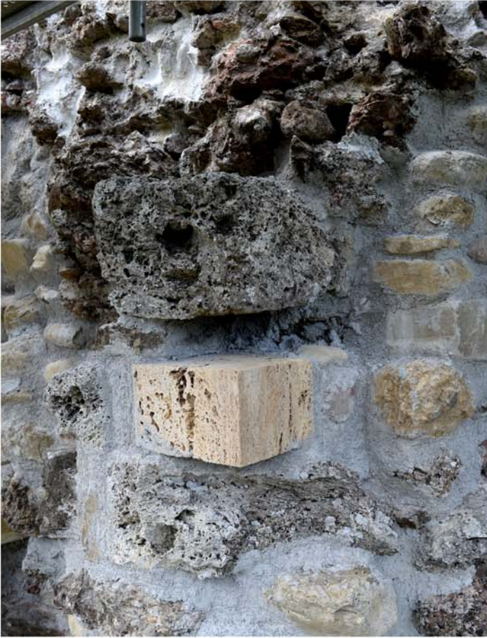
Abb. 13 Schänis SG, Ruine Niederwindegg, 2020. Ecke M1/M2. Zur Stabilisierung der originalen bossierten Tuffsteinquader eingesetzt Ersatzstein mit glatter Oberfläche, von Norden. Vor dem Schliessen der Lücke wurde dort zur rückwärtigen Verankerung der Ecke eine Ankerstange aus Chromstahl eingesetzt.
