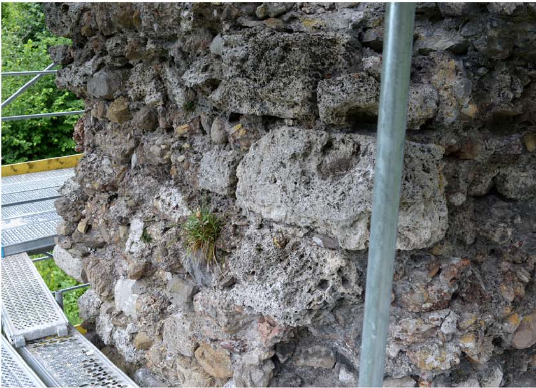
Abb. 25 Schänis SG, Ruine Niederwindegg, 2020. Mauer M2, Absatz, von Osten. Der Mauerabsatz besteht aus schräg abfallend zugehauenen Steinen. Die über dem Absatz liegenden Tuffsteinquader (im Vordergrund) sind Reste des Eckverbandes M2/M3.
